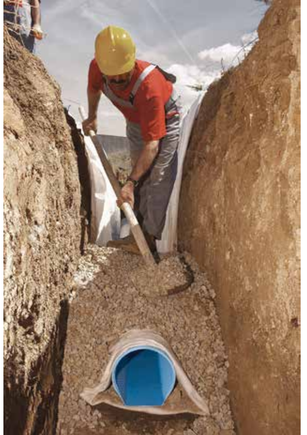
6 7x15 veya 15x25 malzeme boru üzerini kapatacak kadar doldurulur.
