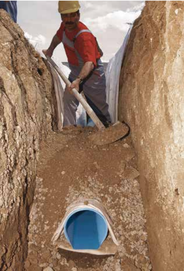
7 Dolgu malzemesi ile doldurulmaya başlanır.
