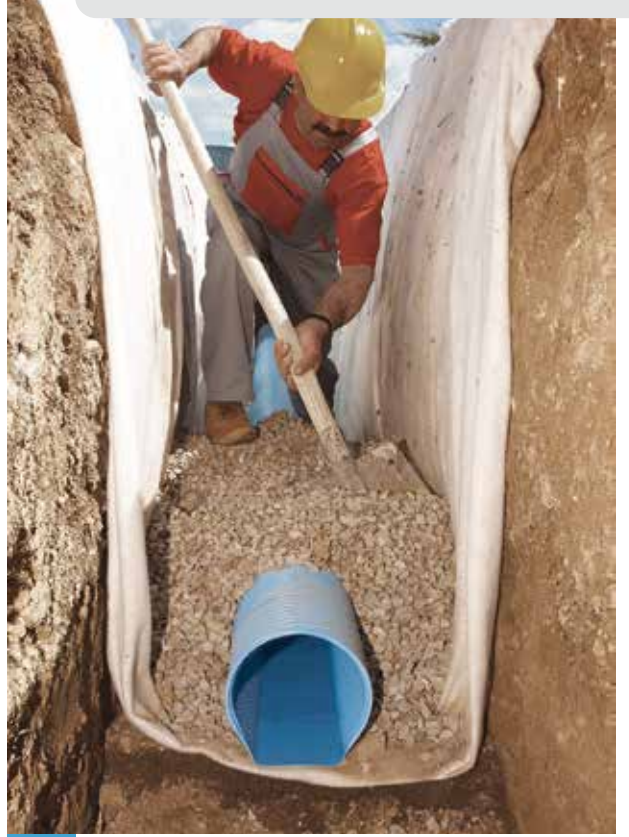
4 Yaklaşık 15cm-20cm, 7x15 veya 15x25 malzeme geotekstil üzerine serilir.
