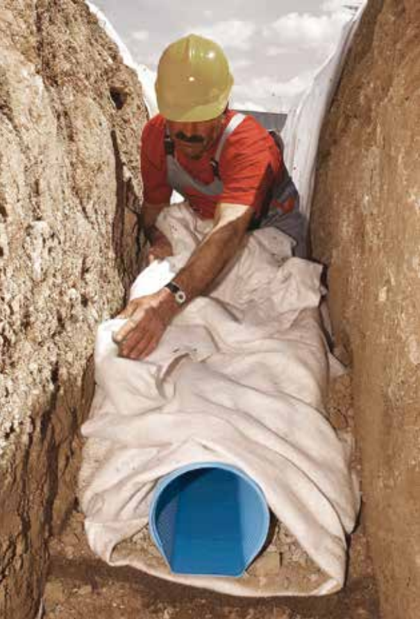
5 Geotekstil boru üzerine bohçalama yapılarak kapatılır.
