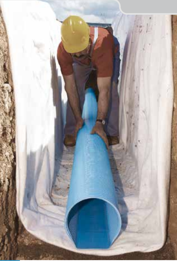
3 Geotekstil üzerine boru yerleştirilir.
