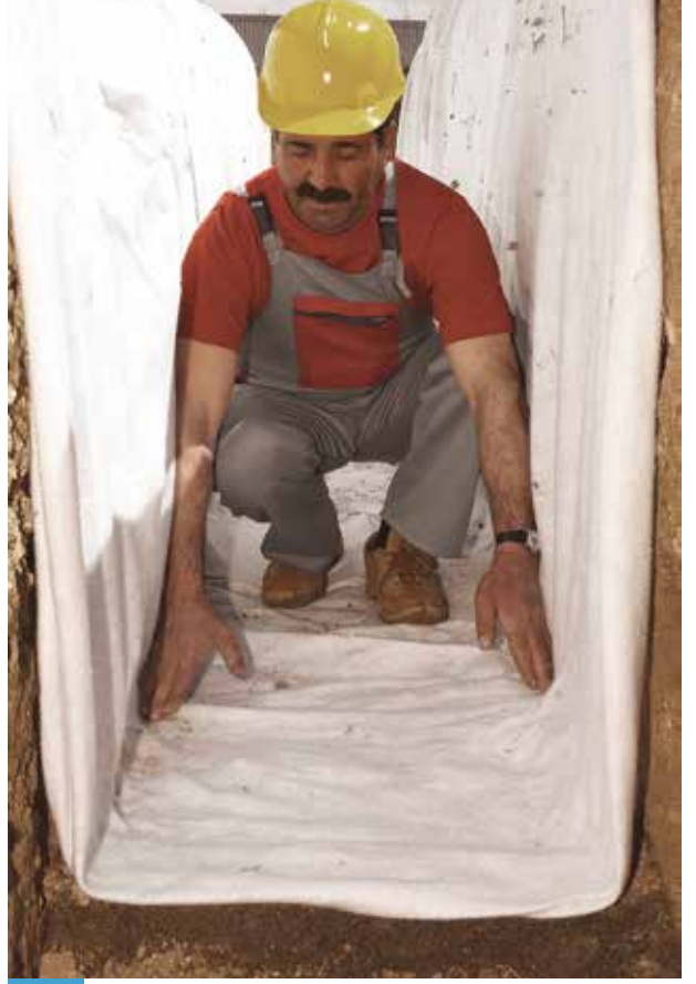
2 Gözeneklerin tıkanmaması için kullanılan geotekstil (150-200 gr/m 2 ) zemine serilir.
