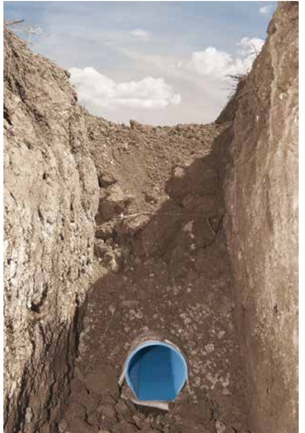
8 Zemin seviyesine kadar dolgu malzemesi doldurulur.
